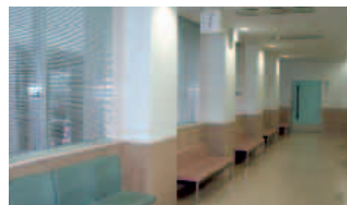
人体感知センサーを設置した廊下
