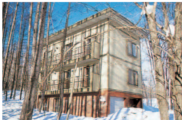
化学物質過敏症研究住宅の建設地は、化学肥料などは使わず、自然の生態系をそのままの形で生かした酪農を実践している斎藤牧場内。
