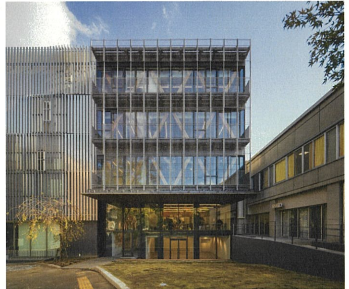
施設名 国際交流棟 (Hisao&Hiroko TAKI PLAZA) 構造・階数 鉄骨造・木造 地上5階建て 延べ面積 1,494.48㎡ 使用開始 2022年11月
