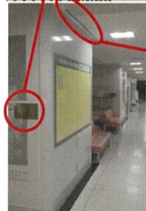
写真① トリアージスペース 医療ガス設備整備
